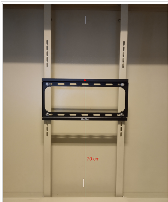
Fig. 15 : Fijación de soporte al gabinete.
