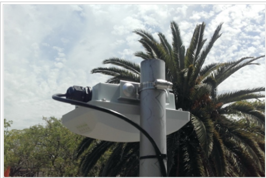
Fig. 1 - Equipo Ruckus T300 fijado a caño
