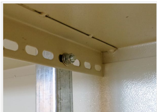
Fig. 1 : Ajuste de posición de parantes.
