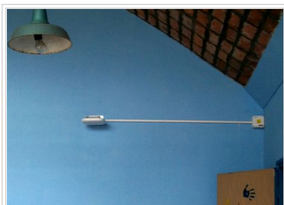
Fig. 14 - Instalación de AP en pared reutilizando cableado existente
