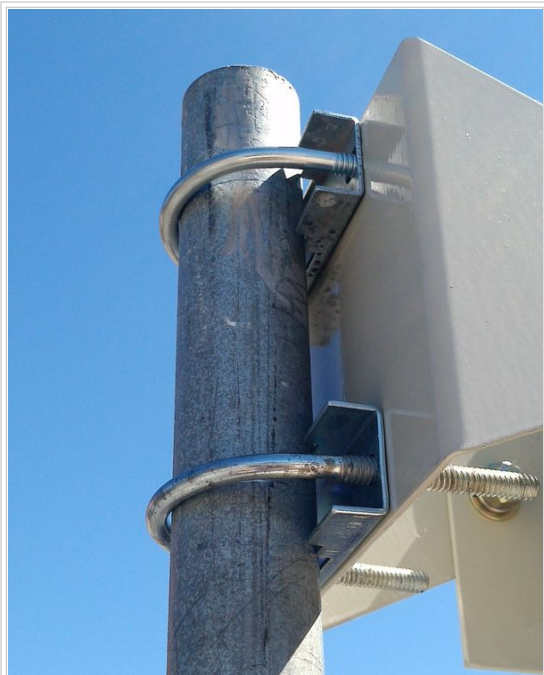
Fig. 3 - Fijación del soporte al caño
