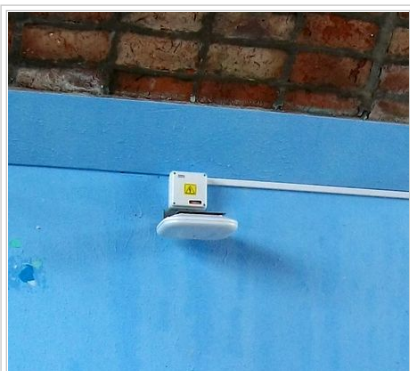
Fig. 13 - Instalación de AP en pared junto a caja de jack
