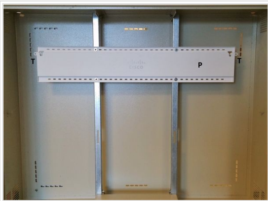
Fig. 2 : Instalación de platina de montaje.
