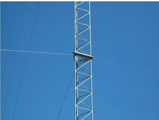
Fig. 3 – Unión entre tramos
