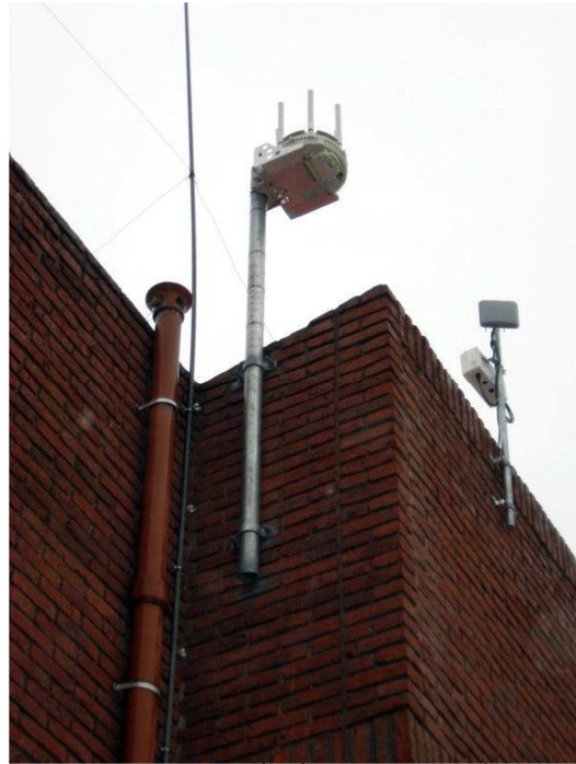
Fig. 12 – Instalación en caño amurado
