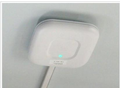
Fig. 2 - AP Cisco fijado a cielorraso común
