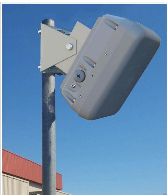
Fig. 1 - Equipo Cisco 1562-D fijado a caño
