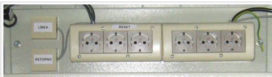
Fig. 6 : Bandeja eléctrica sin bornera
