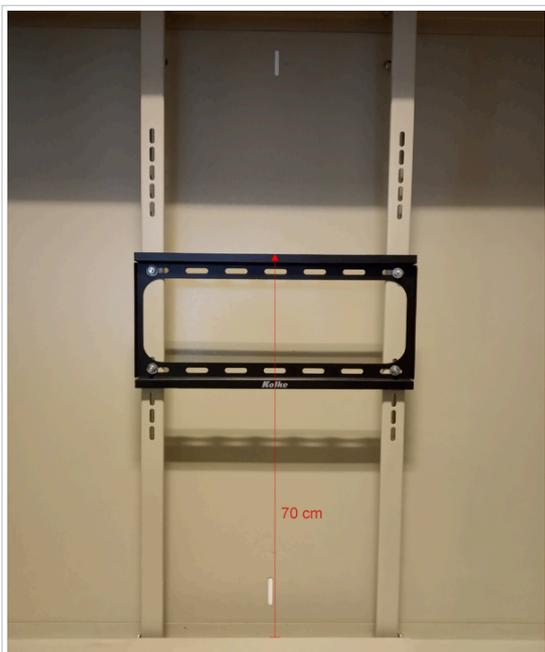
Fig. 15 : Fijación de soporte al gabinete.
