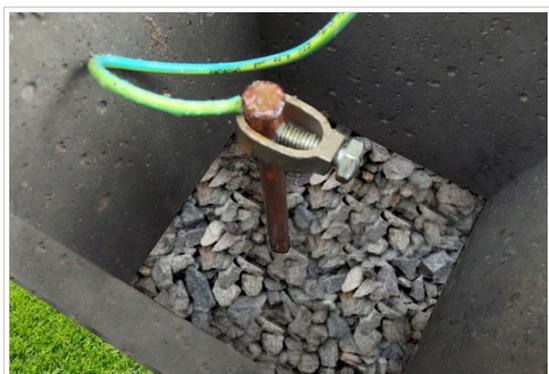
Fig. 2 : Cámara de puesta a tierra
