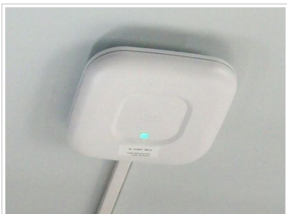
Fig. 2 - AP Cisco fijado a cielorraso común
