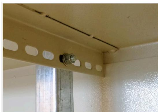
Fig. 1 : Ajuste de posición de parantes.
