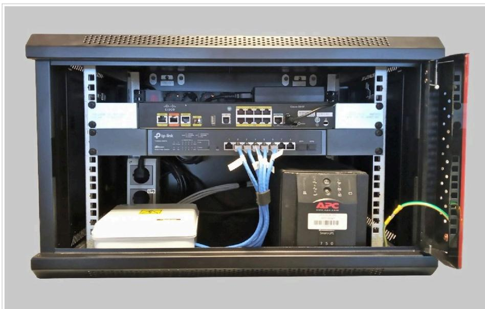
Fig. 4 : Disposición de equipos en rack 6U
