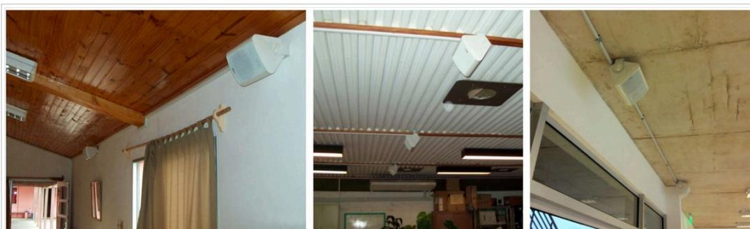
Fig. 10 : Ejemplos de instalación de parlantes.
