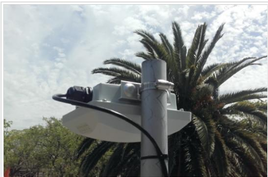
Fig. 1 - Equipo Ruckus T300 fijado a caño
