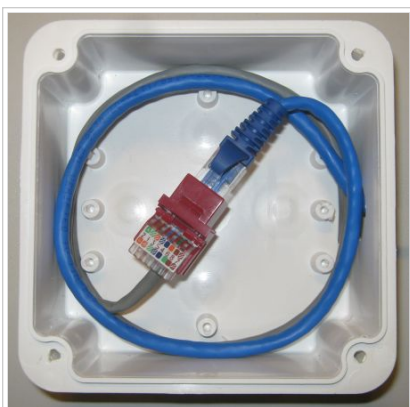
Fig. 1 Jack en caja de registro exterior
