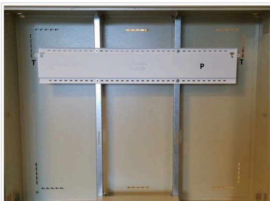
Fig. 2 : Instalación de platina de montaje.
