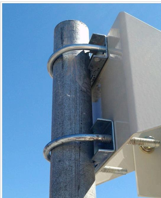
Fig. 3 - Fijación del soporte al caño
