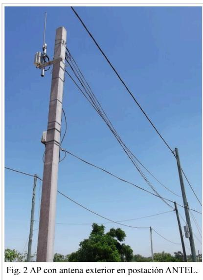
Fig. 2 AP con antena exterior en postación ANTEL.
