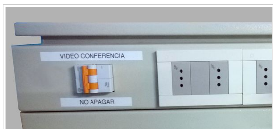
Fig. 3 : Derivación de VC desde rack 19" 20 o 25 U.
