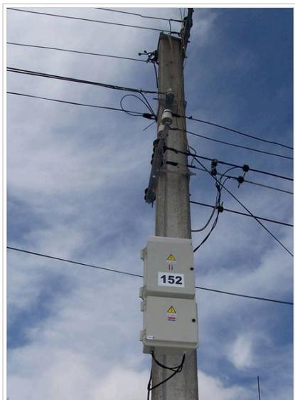
Fig. 1 Gabinete con AP y antena integrada.
