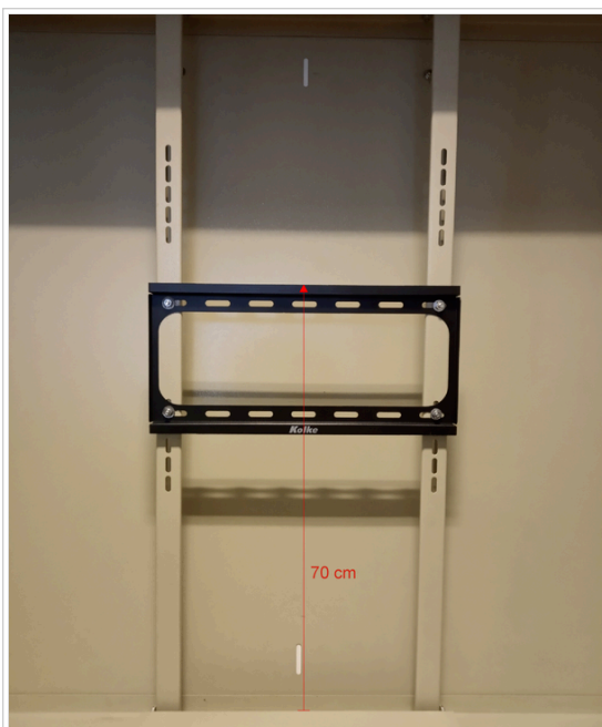
Fig. 15 : Fijación de soporte al gabinete.
