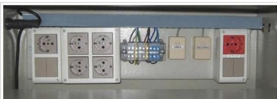
Fig. 4 : Bandeja eléctrica con bornera
