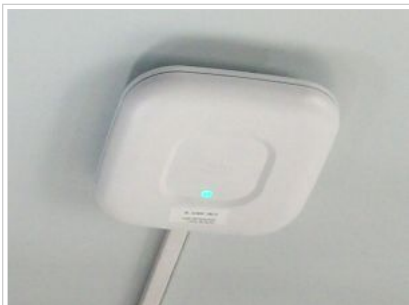
Fig. 2 - AP Cisco fijado a cielorraso común
