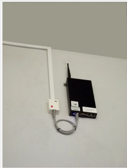
Fig. 1 - AP Mikrotik interior
