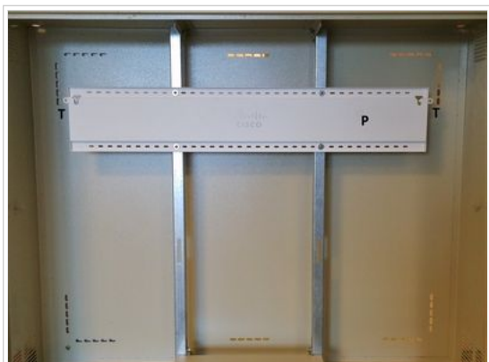
Fig. 2 : Instalación de platina de montaje.
