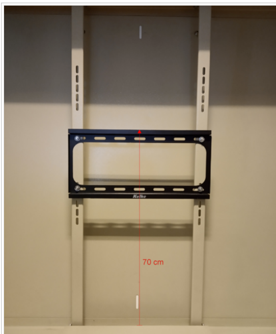
Fig. 15 : Fijación de soporte al gabinete.
