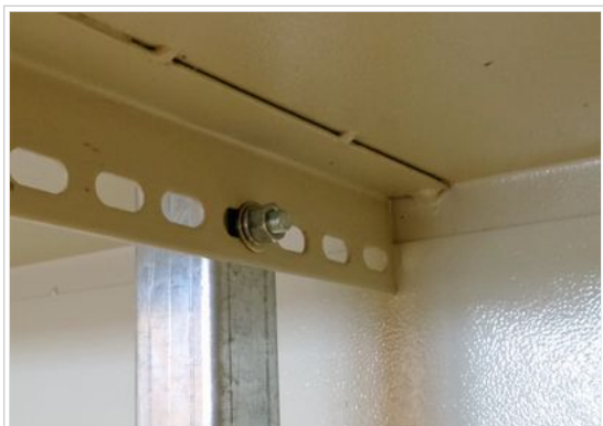
Fig. 1 : Ajuste de posición de parantes.
