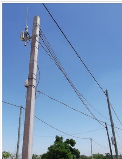
Fig. 2 AP con antena exterior en postación ANTEL.
