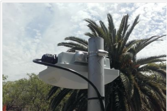
Fig. 1 - Equipo Ruckus T300 fijado a caño
