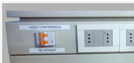
Fig. 3 : Derivación de VC desde rack 19" 20 o 25 U.
