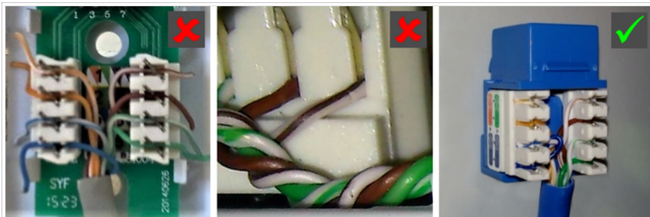
Fig. 5 - Crimpado de jacks
