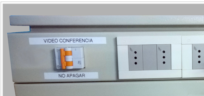
Fig. 2 : Derivación de VC desde rack 19" 20 o 25 U.
