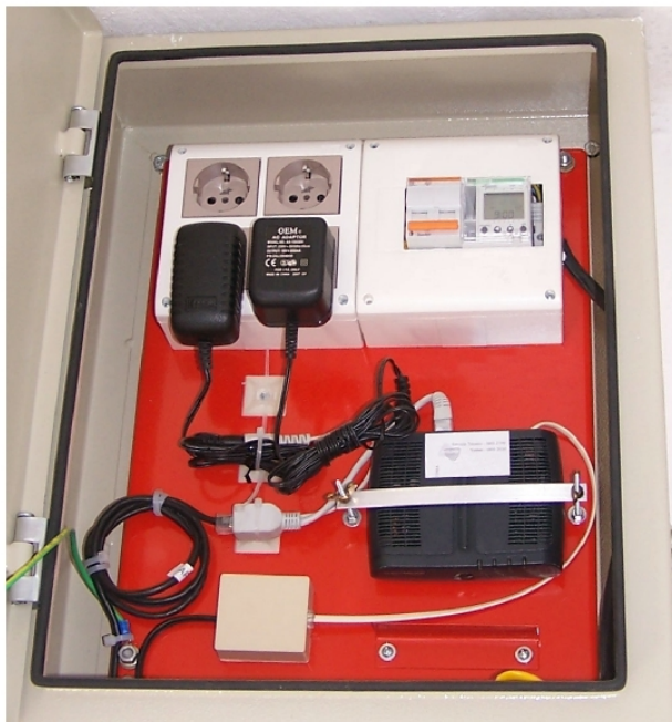
(B) Gabinete bandeja simple cableado (c/ interruptor horario semanal)
