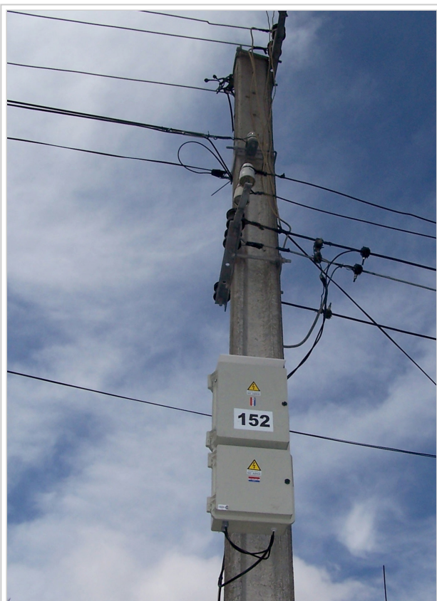
Fig. 1 Gabinete con AP y antena integrada.
