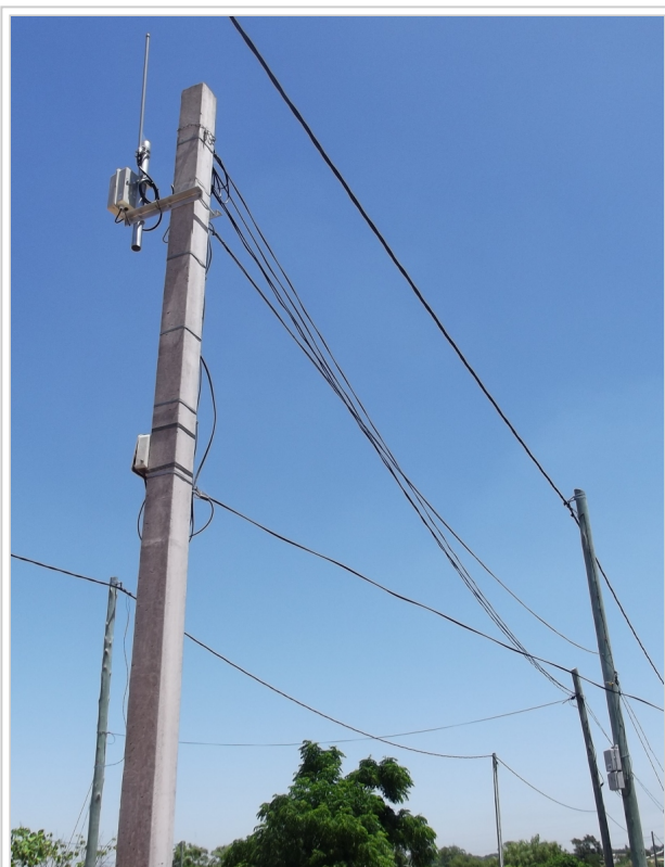
Fig. 2 AP con antena exterior en postación ANTEL.
