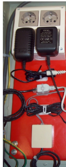
(C) Gabinete bandeja simple cableado (c/ interruptor horario diario)
