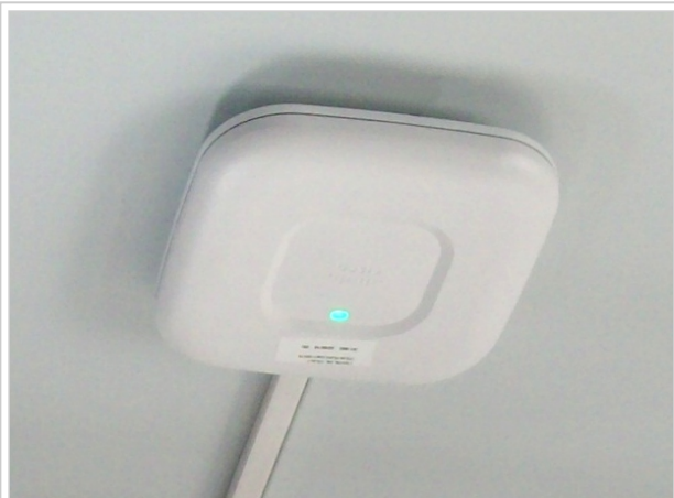
Fig. 2 - AP Cisco fijado a cielorraso común
