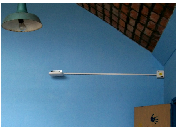
Fig. 14 - Instalación de AP en pared reutilizando cableado
