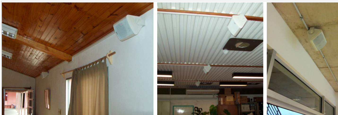
Fig. 4 : Ejemplos de instalación de parlantes.
