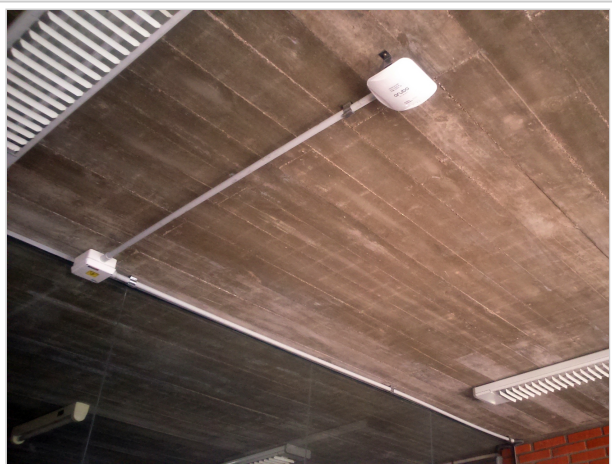
Fig. 1 - AP Aruba fijado a cielorraso común
