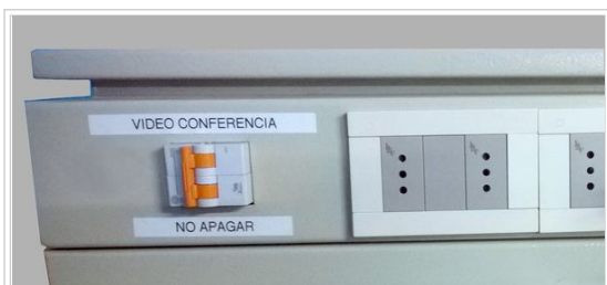
Fig. 2 : Derivación de VC desde rack 19" 20 o 25 U.
