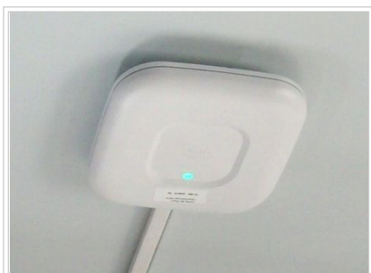
Fig. 2 - AP Cisco fijado a cielorraso común
