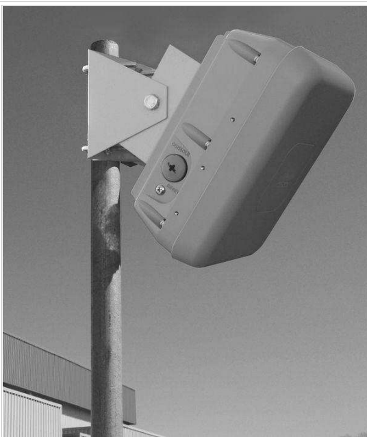
Fig. 1 - Equipo Cisco 1562-D fijado a caño
