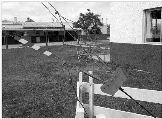
Fig. 5 - Señalización de riendas
