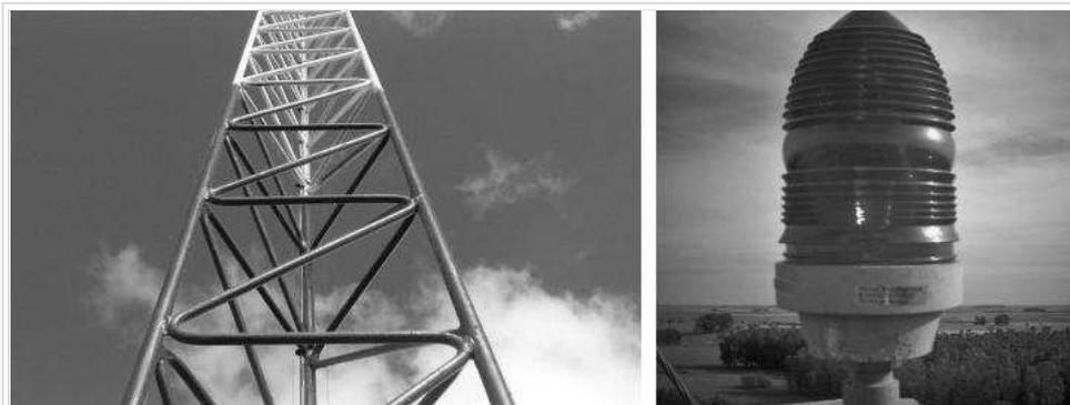
Fig. 9 - Balizamiento diurno (izq), Balizamiento nocturno (der)
