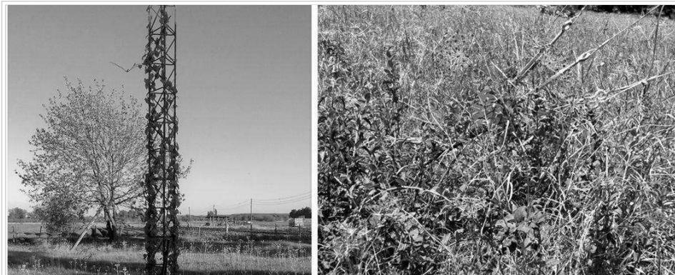
Fig. 8 - Ejemplos de vegetación en componentes del mástil
